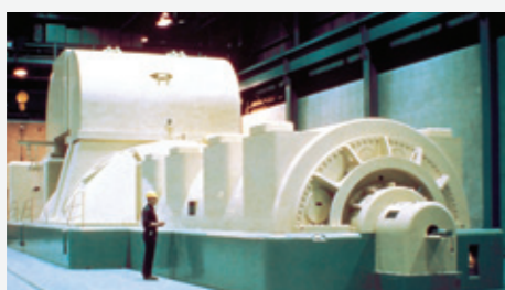
MOTORES Y GENERADORES
