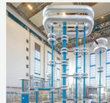
ENSAYOS DE IMPULSOS DE TENSIÓN
