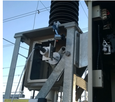
Transductor rotativo digital montado en un interruptor de SF6 modelo ABB LTB de 245 kV
